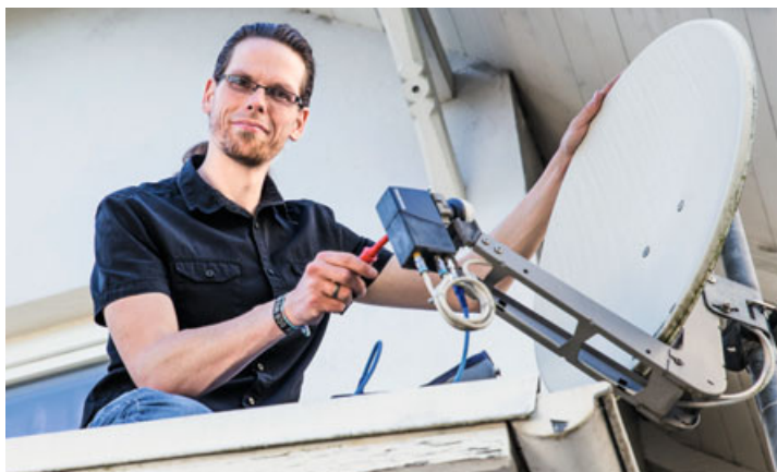
Torsten Richter bei Außeninstallationsarbeiten: auch vor Ort der richtige Ansprechpartner.
