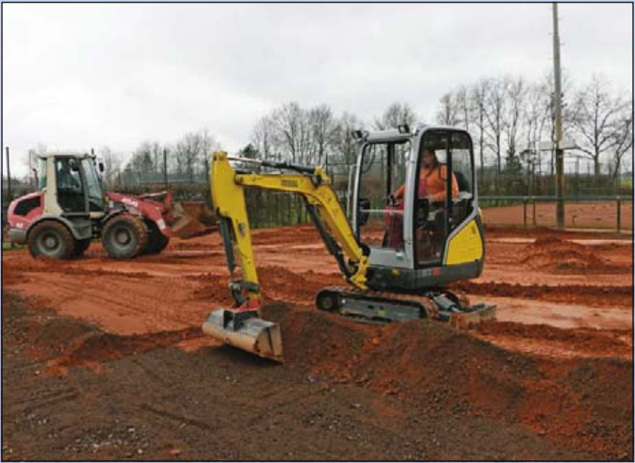
Es beginnt mit dem Ausbaggern: Abtragen der kompletten Ziegelmehldecke.
